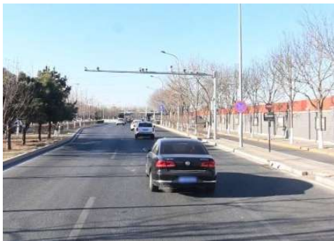
图 2-23 东坝南二街现状道路
